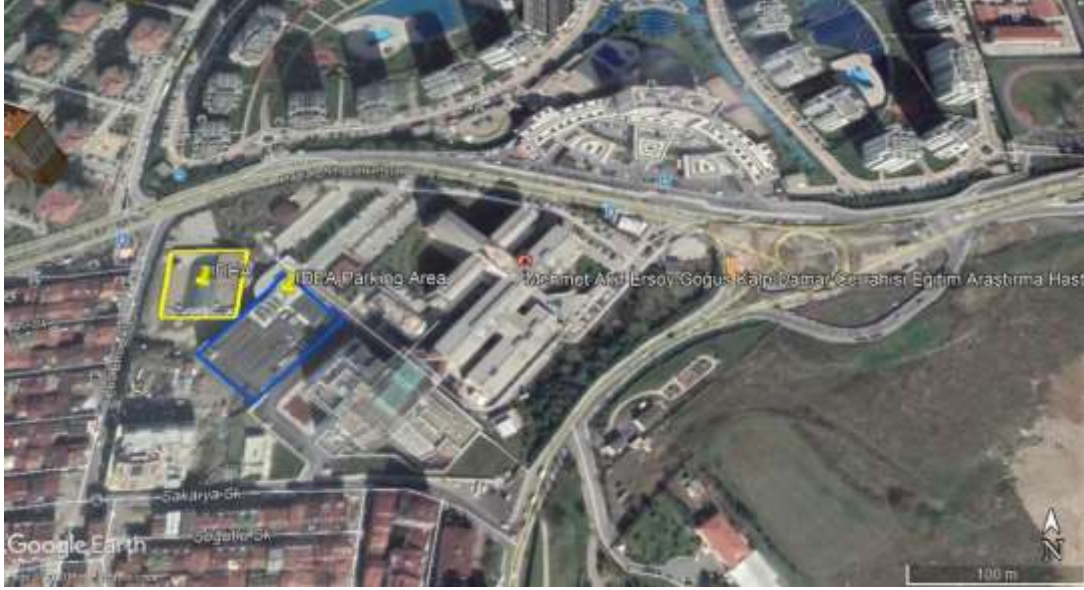
Şekil 8: İDEA'nın Havadan Görünümü - Küçükçekmece
